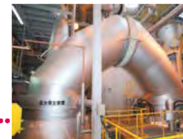
温水発生装置 熱を回収して温水をつくります。
