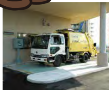
計量機 運ばれてきたゴミの重さを計ります。
