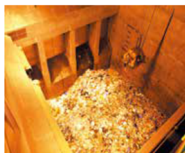
ゴミピット ゴミをいったんためておく場所です。 ここでゴミをよく混ぜます。
