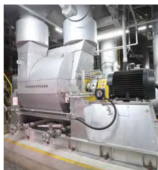
■下段押込送風機 余熱を利用した高温空気でコークスの使用量を減らします。
