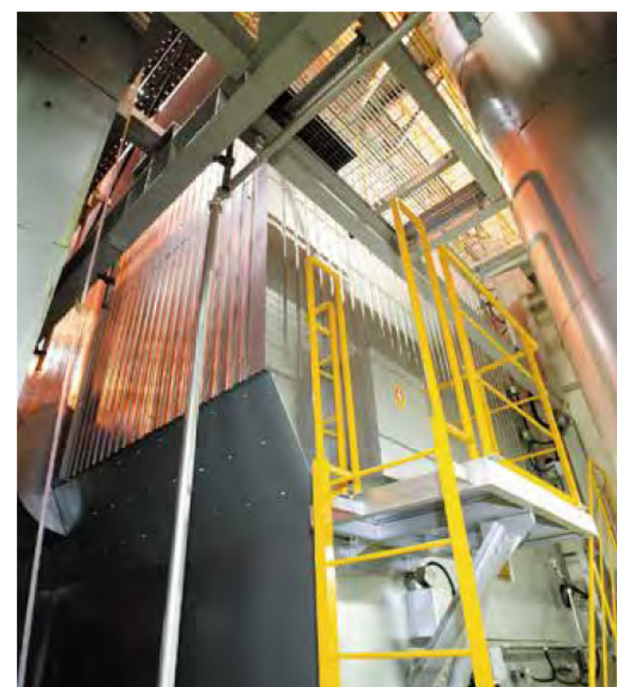
■ろ過式集じん器(バグフィルタ) 排ガスに含まれる細かい飛灰などを内部のろ布で捕集します。
